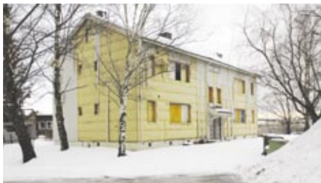
Klæbuveien 209. Her skal det bygges det bysekretariatet i Trondheim omtaler som nye "institusjonsboliger" for mennesker med utviklingshemning.
