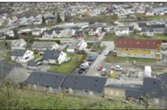
Noen av de gråbeisede leilighetene i Stedjevegen (helt foran) – sett fra oven.
